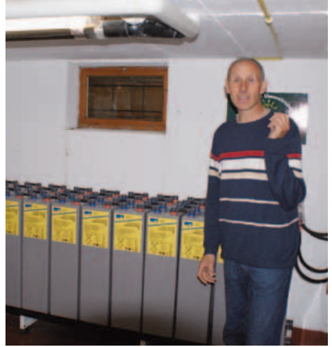
Werner Hellweger im Batterieraum Foto: K. Scherfling
